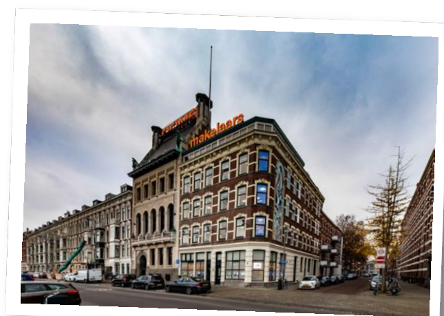
Maaskade 113, 3071 NJ Rotterdam
