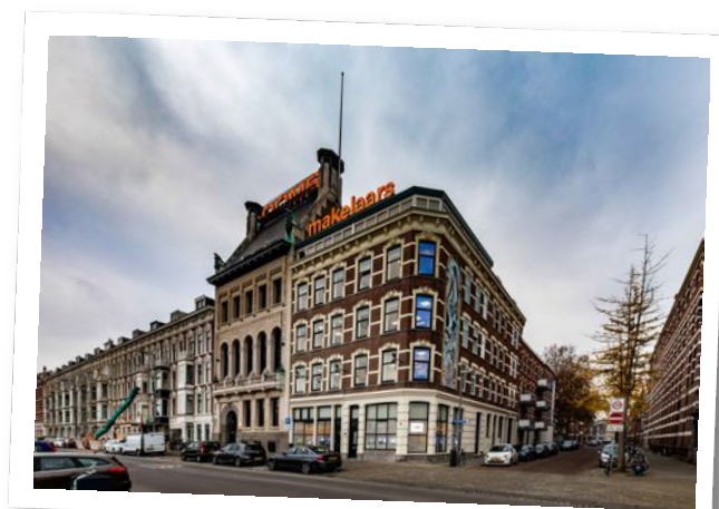
Maaskade 113, 3071 NJ Rotterdam
