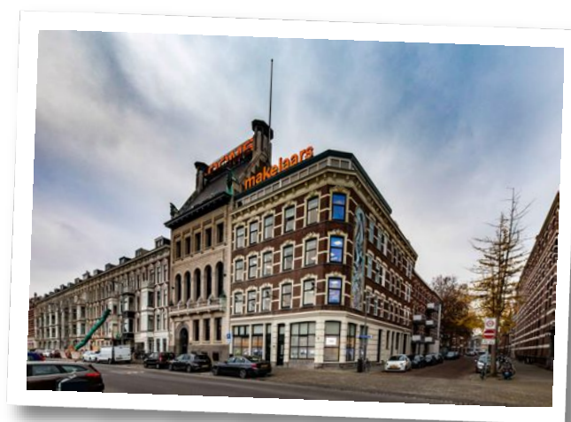
Maaskade 113, 3071 NJ Rotterdam
